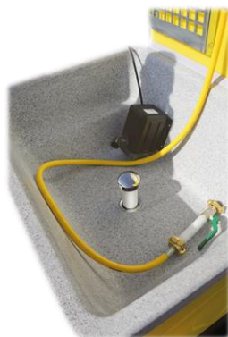
Umwälzpumpe und Push-Open-Ventil
