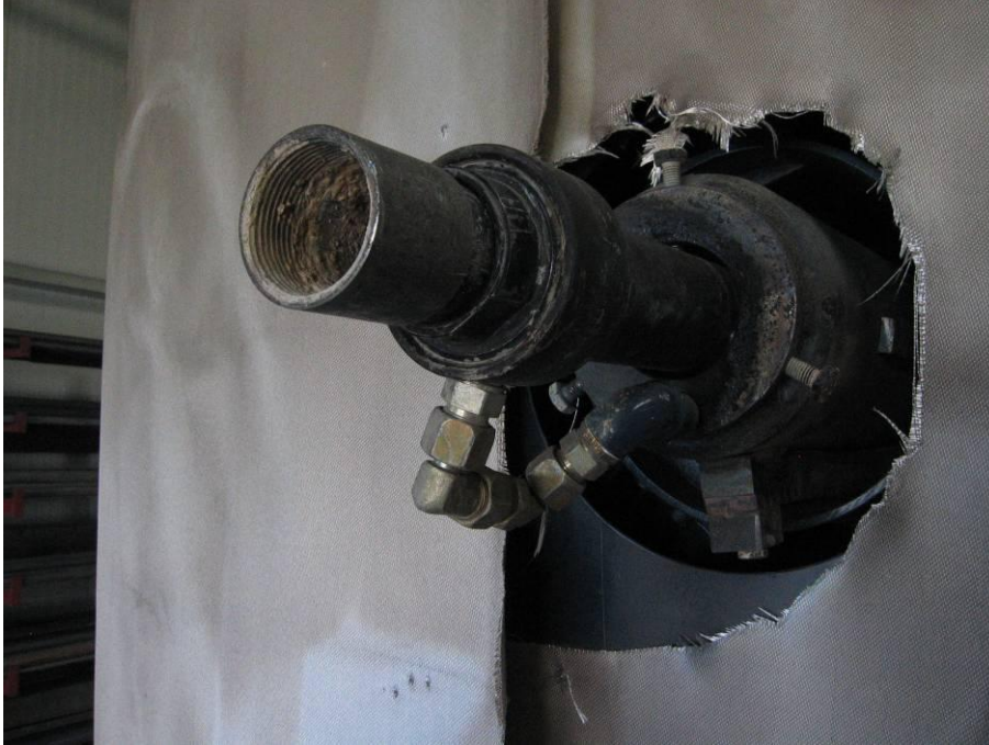
Bild 4-6: Anschluss für die Spritzlanze
